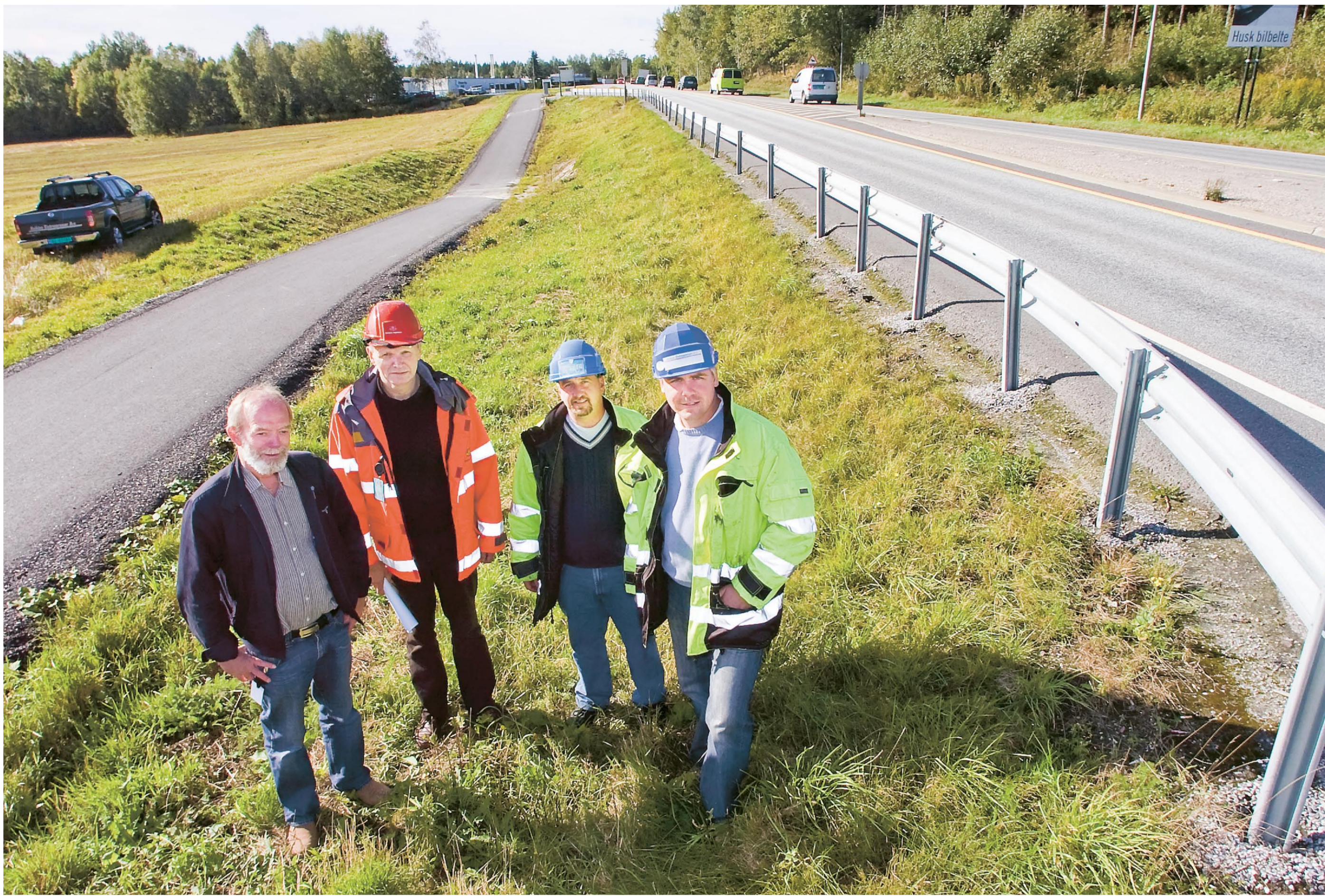
Tunnelen blir på det laveste punktet litt vest for den parkerte bilen. I går var det byggemøte der deltagere var prosjektleder Torgeir Solli (fv) fra Covi, vegkontorets prosjektleder Bjørn Berge Hansen og entreprenørens representanter, prosjektleder Jørn Tore Mäleng og anleggsleder Kjell Arne Linnerud.
