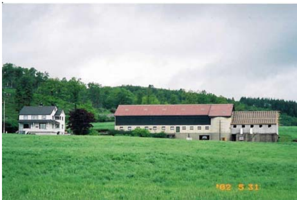
Bilde 2. Oppføring av tilbygg på Eigeland
