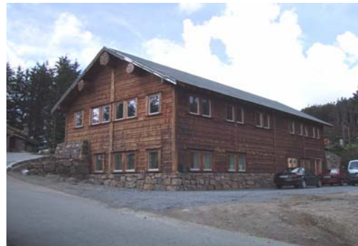
Bilde 29. Bygget sett utenfra. De stor takåsene og sitkagran som kledning.
