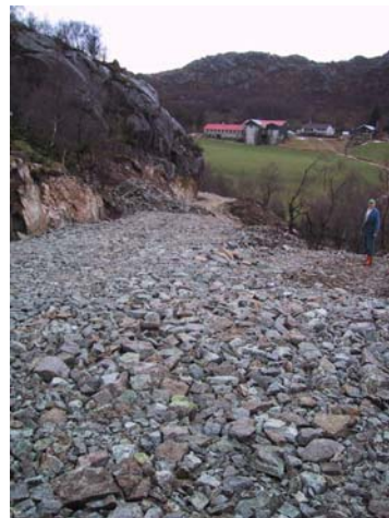
Bilde 32. Fundamentering av skogsbilvei. Ringveien med Nodland i bakgrunnen.
