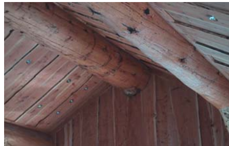
Bilde 28. Den store sitkagrana har blitt takås. Flaskeskåren lerk med innfelte lys som himling.
