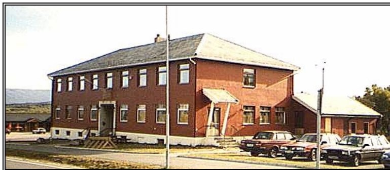
Gamle rådhuset i Lakselv. Oppført 1955.
