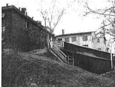
Fyranlegg med flissilo (sjukehjemmet bak)
