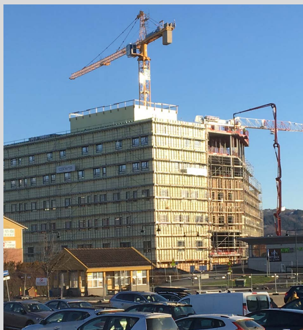
Region Nordhordland Helsehus under bygging, hausten 2019.
