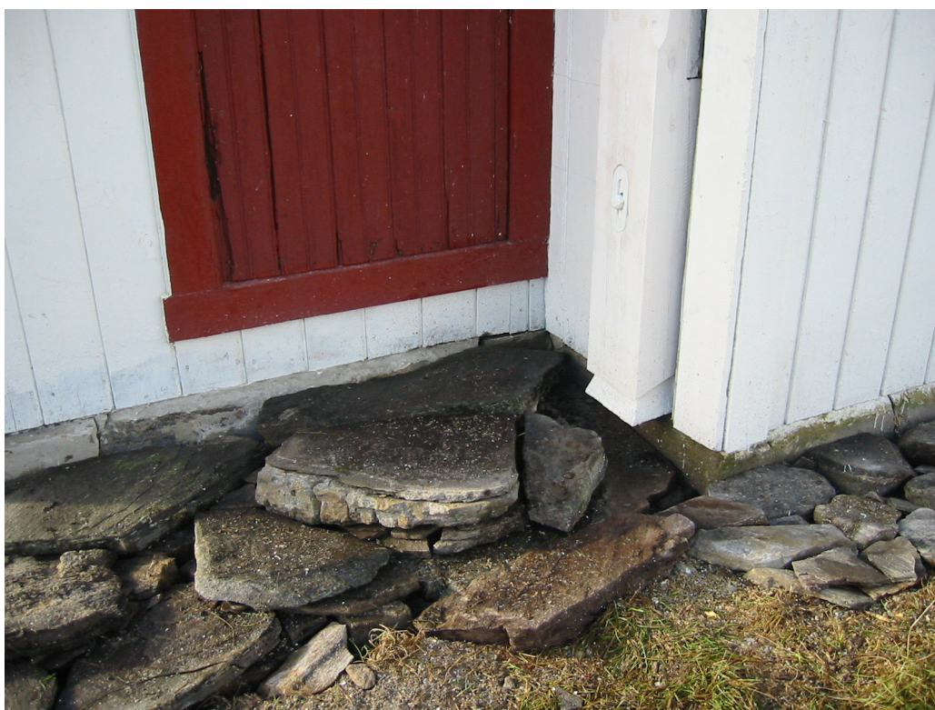
Bilde 25: Baktrapp etter utbedring (Foto: G. B.).
