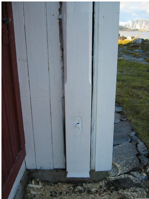
Bilde 16: Ferdig utbedret (Foto: G. B.).
