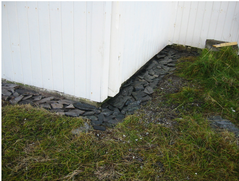
Bilde 7: Steinsetting rundt grunnmur (Foto: G. B.).
