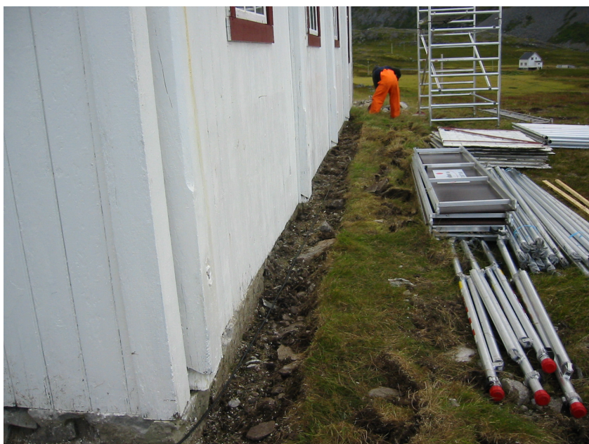
Bilde 8: Grøfting før steinsetting (Foto: G. B.).
