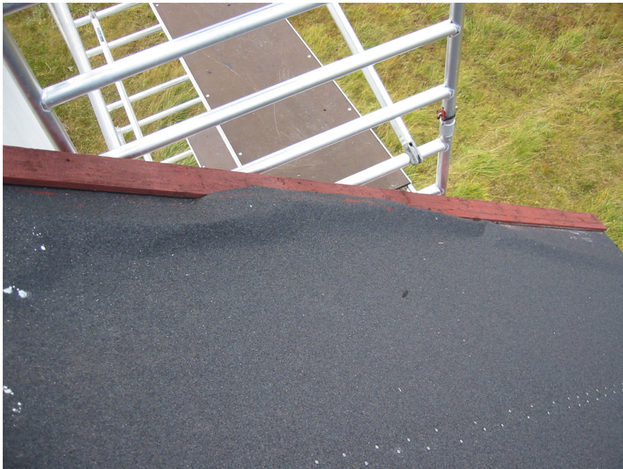
Bilde 27: Løs papp på hovedtak (Foto: G. B.).
