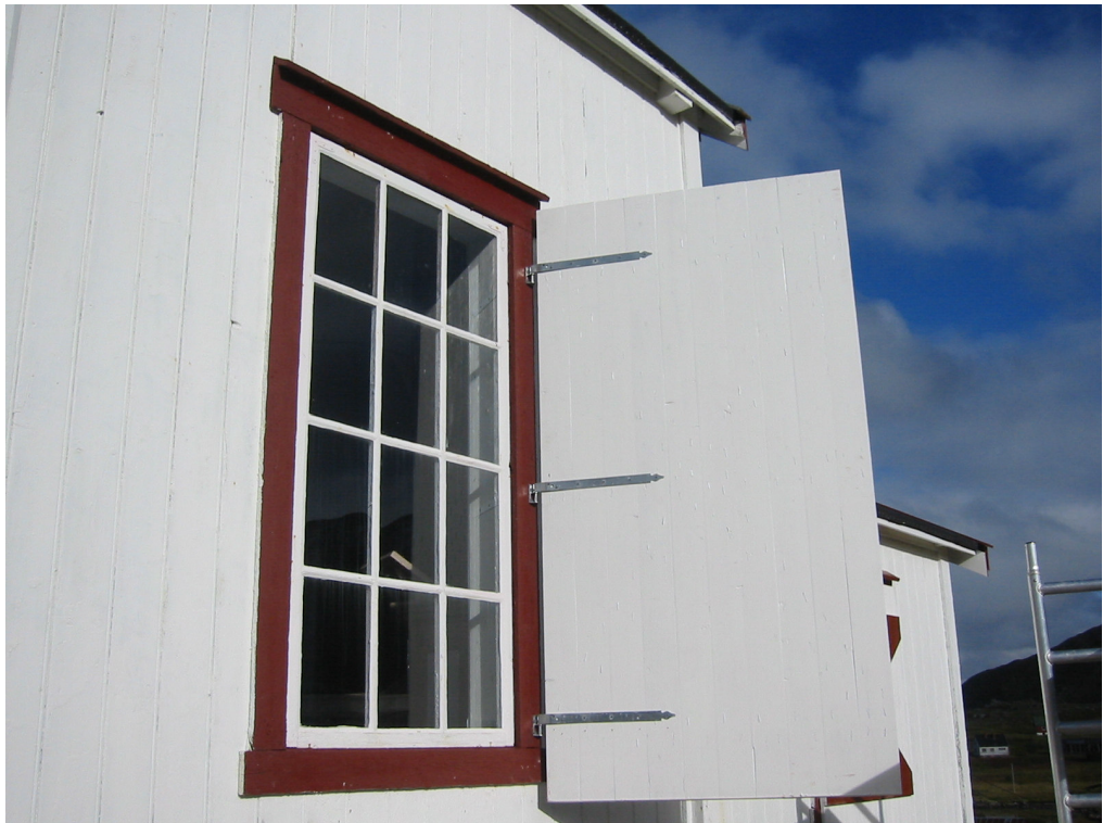
Bilde 21: Nye vinduslemmer, åpne (Foto: G. B.).
