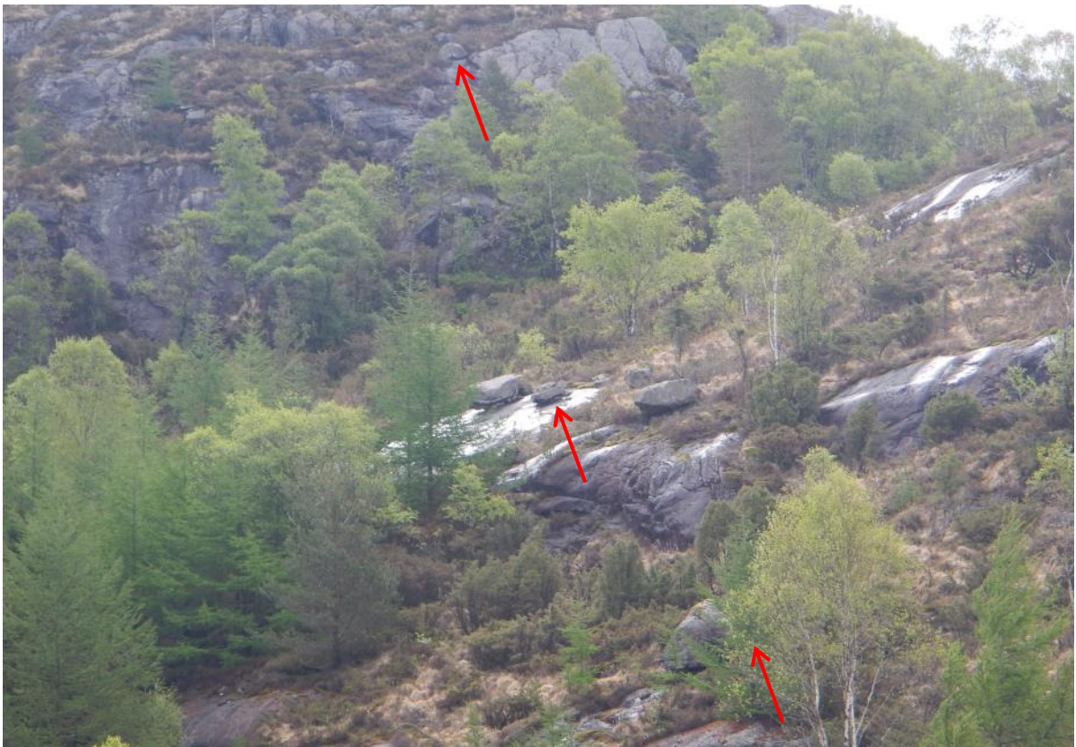
Foto 10 Fjellsiden mot Eikeliknuten, eksempel på blokker som kan være ustabile
