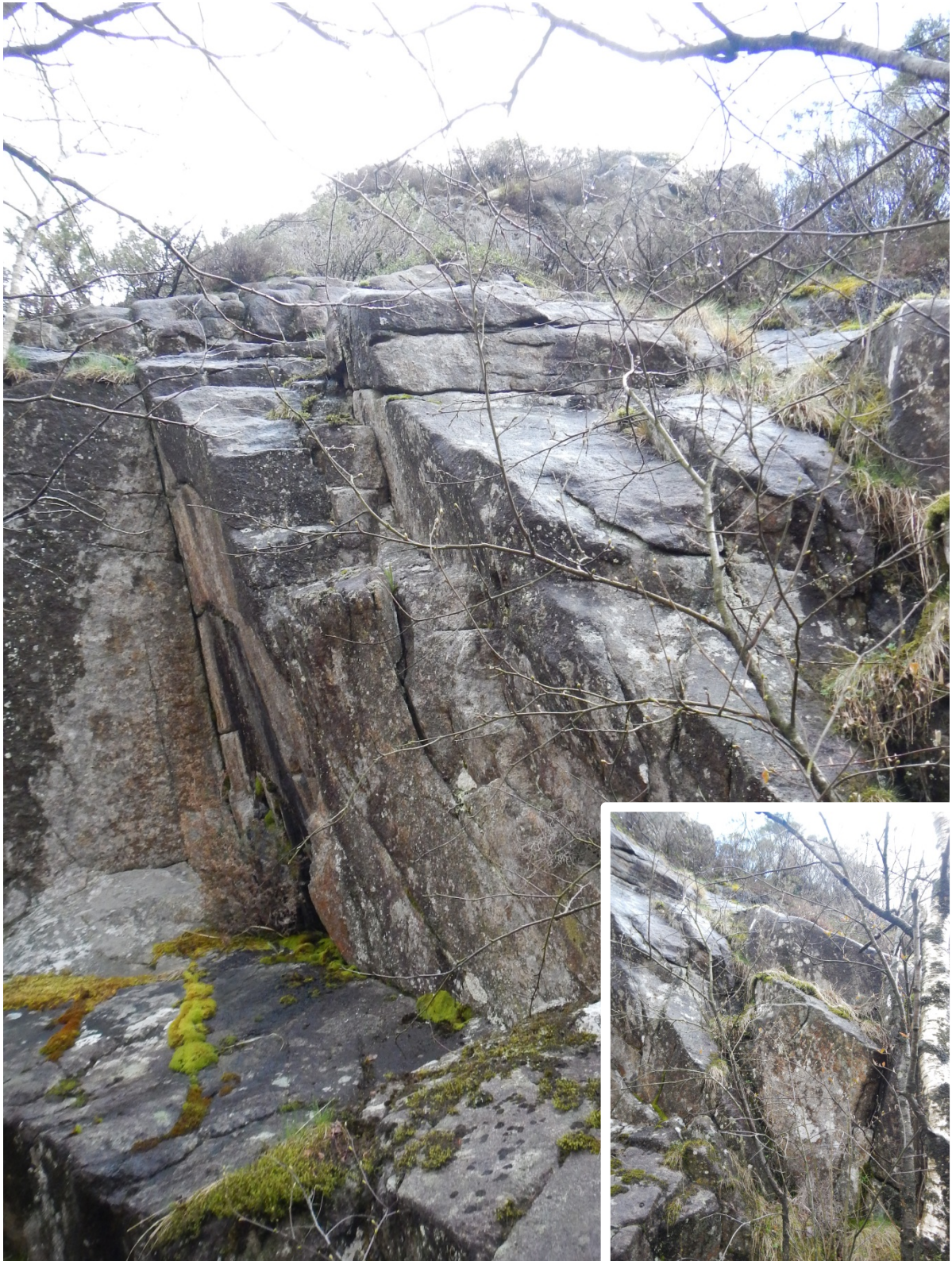
Foto 3: Blokkparti med markert baksprekk ved tomt 54. Bilde nede til høyre viser kile med usikker stabilitet til høyre for blokkparti.
