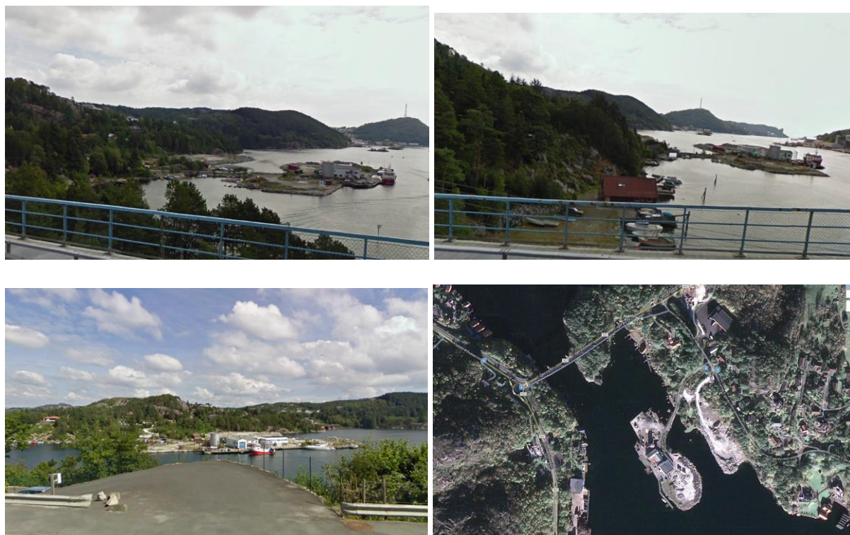
Figur 3.4. Planområdet sett fra Eigerøy bru (øverst), Hovlandsveien (nederst t.v.) samt ortofoto (nederst t.h.).
