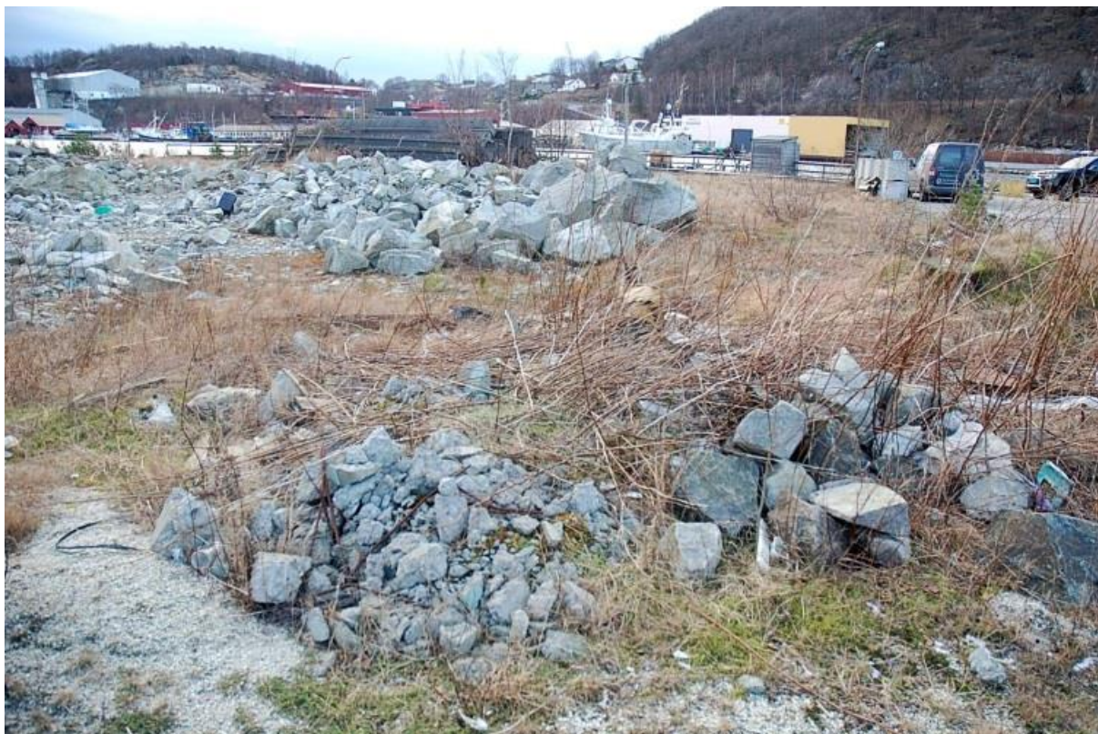
Figur 12.2. Bilde tatt 17.01.14 Søndre del av øya. Massene er i stor grad påfyllingsmasser med mye stor stein.
