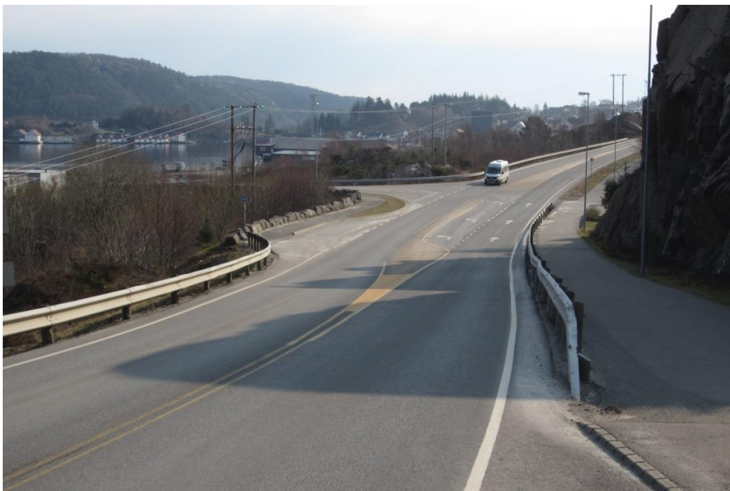
Bilde 21- Kryss 2 mot sør, bussholdeplassen ligger nord for krysset, gående må krysse bak autovernet midt i krysset
