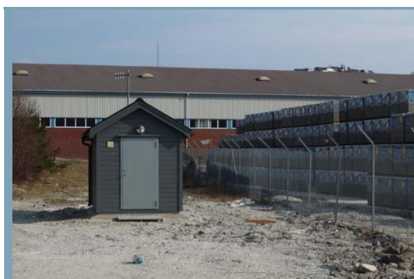
Figur 46: Eksisterende pumpehus nord for Icopal, reguleres til øvrige kom.tekniske anlegg; Foto: Norconsult
