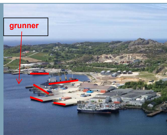
Figur 30: Kai ved Nordsjøterminalen og kaier Kaupanes; Foto: Norconsult
