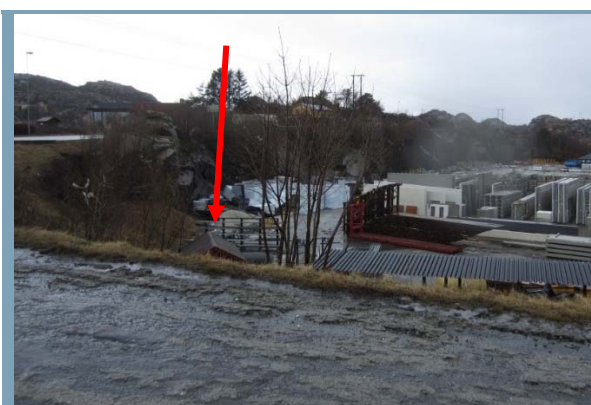
Figur 47: Eksisterende pumpehus nord for avkjørsel til Bertelsen & Garpestad reguleres til øvrige kom.tekniske anlegg; Foto: Norconsult
