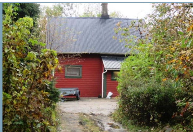
Figur 88: Våningshus – Grønehaugveien 33, sett fra nord, Foto: Norconsult 10/2015
