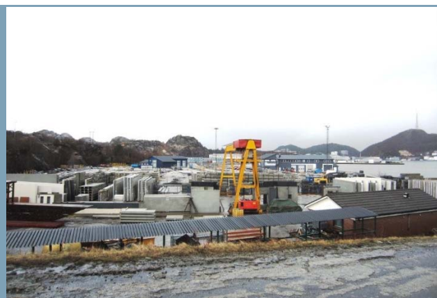
Figur 57: Bruk av H/I/L 6, lager betongelementer
