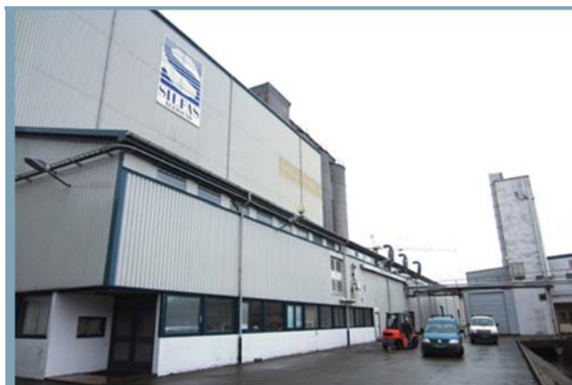
Figur 54: Silfas, tidl. siloljefabrikk innenfor HIL 2 sett fra kaiaen, Norconsult febr. 2015
