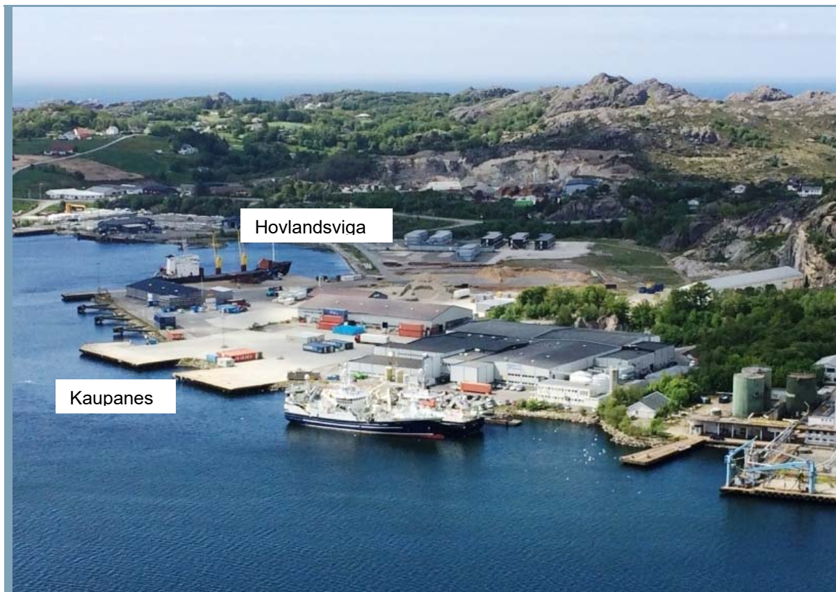
Figur 66: Havneområdet fra Kaupanes til Hovlandsviga og Nordbø, Norconsult juni 2015
