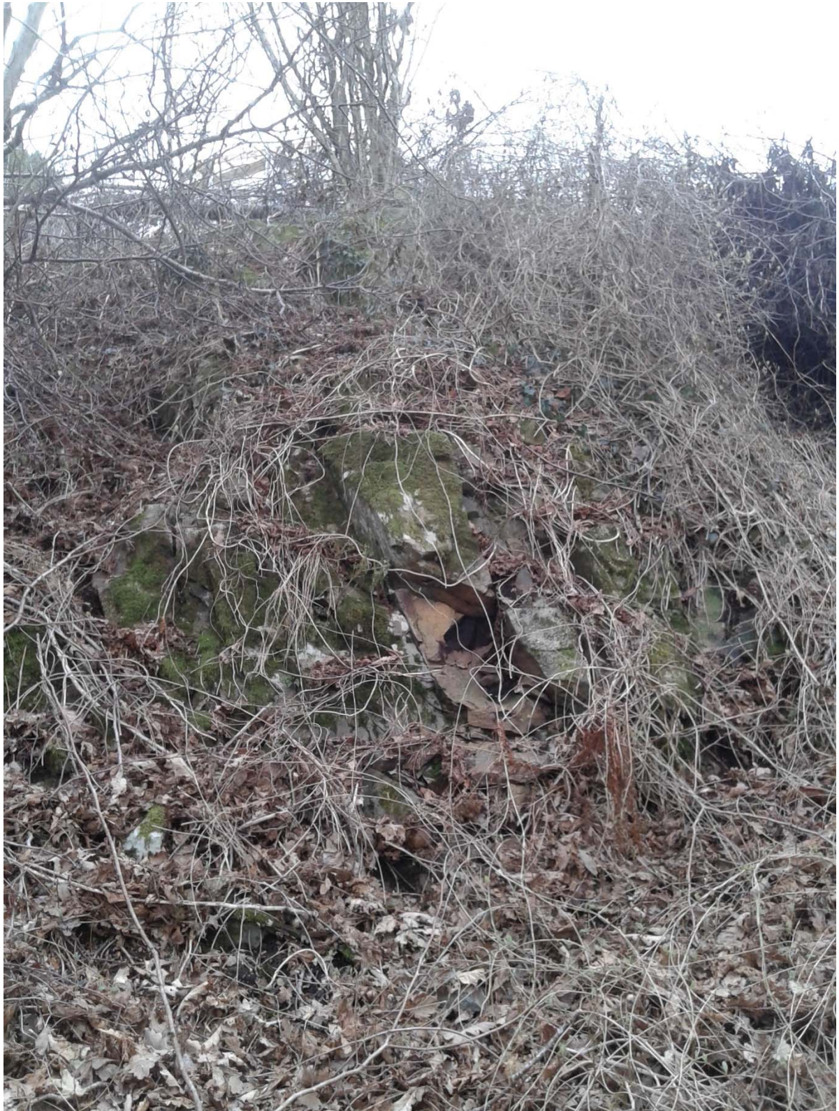
Foto 4 Lokaltet 1. Vegetasjonen må renskes, og aktuelle sikringstiltak er steinsprangnett og bolter.
