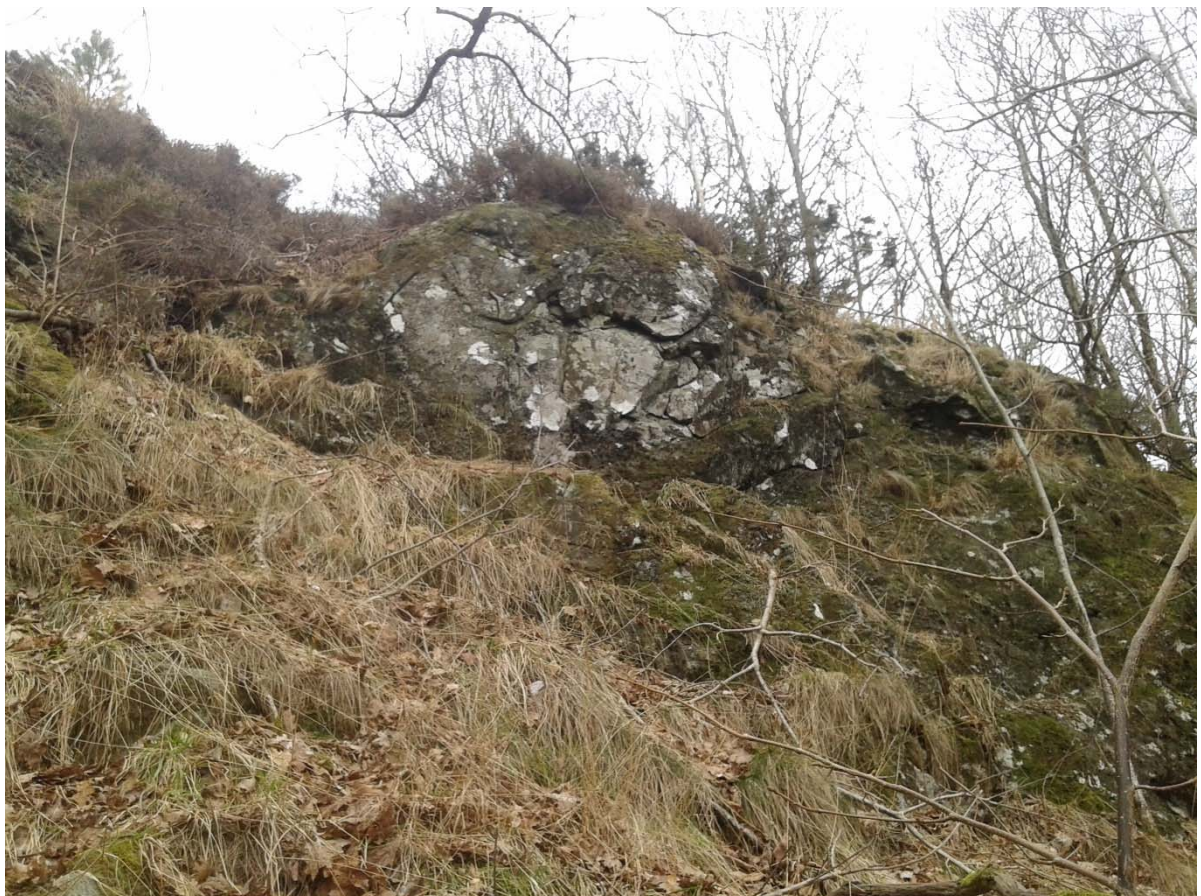
Foto 14 Lokalitet 11. Aktuelle sikringstiltak er rensk, bolter og steinsprangnett
