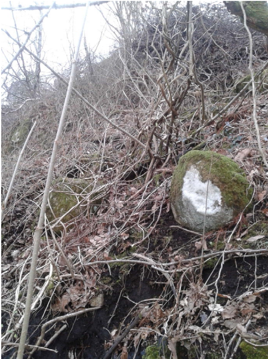
Foto 5 Lokalitet 2. Eksempel på løs blokk i skråningen. Blokk kan renskes ned.
