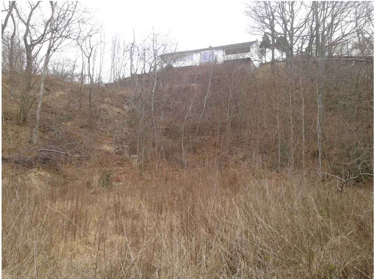
Foto 1 Skråning ovenfor BBB1
