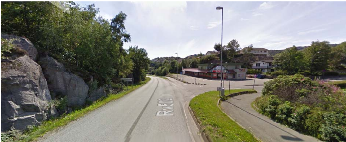
Figur 9: Dagens kryssløsning Hovlandsveien – Uførjellveien. Fotokilde: www.google.no/maps/
