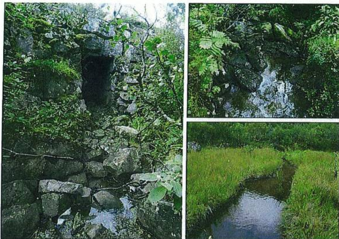
Figur 14. Venstre: Bekken fra Kobbvågvatnet renner igjennom steinfylling, under eksisterende fylkesvei. Høyre: I øvre del av utløpsbekken er stein dominerende substrat (øverst), mens det er mest grov grus før utløpet i sjø (nederst). Før utløpet renner bekken i naturtypen strandeng og strandsump.
