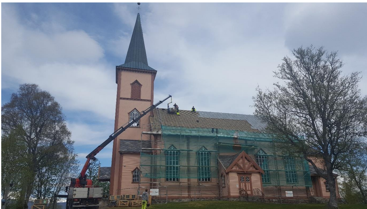
Taket på Røsvik kirke ble renoveret i 2017. Foto: Rita Berg
