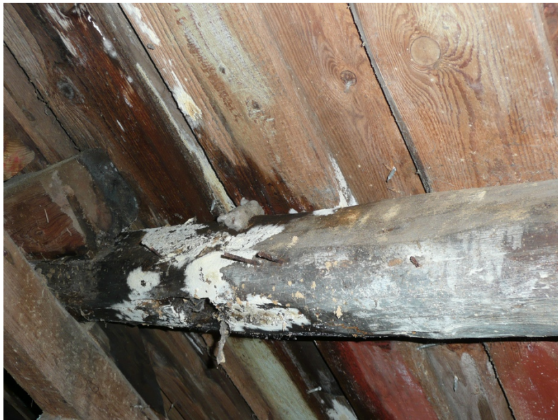
Råteskader på sutak og takåser.
