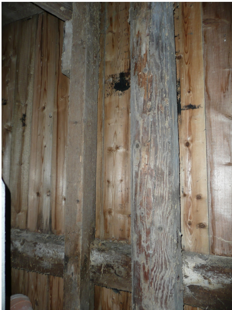
Råteskader på sutak og takåser.
