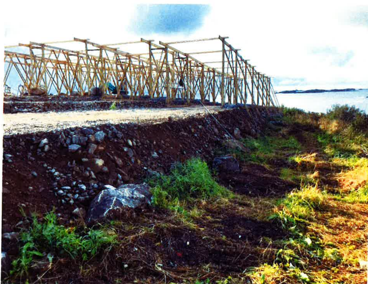
Bildene viser nordvestsiden sett fra sør og nord.
