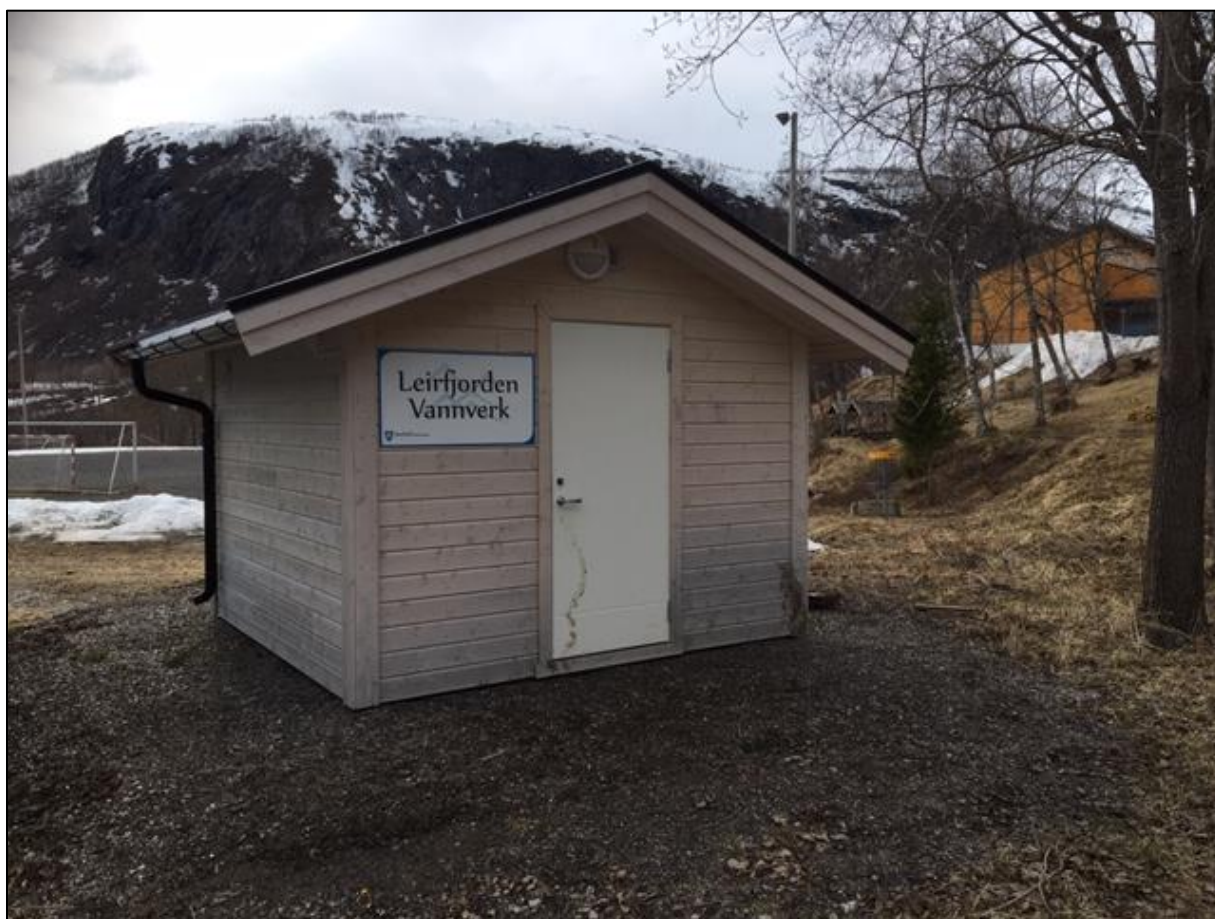
Nytt vannverksbygg i 2018. Foto: Anne Lise Nordvik Arntzen.
