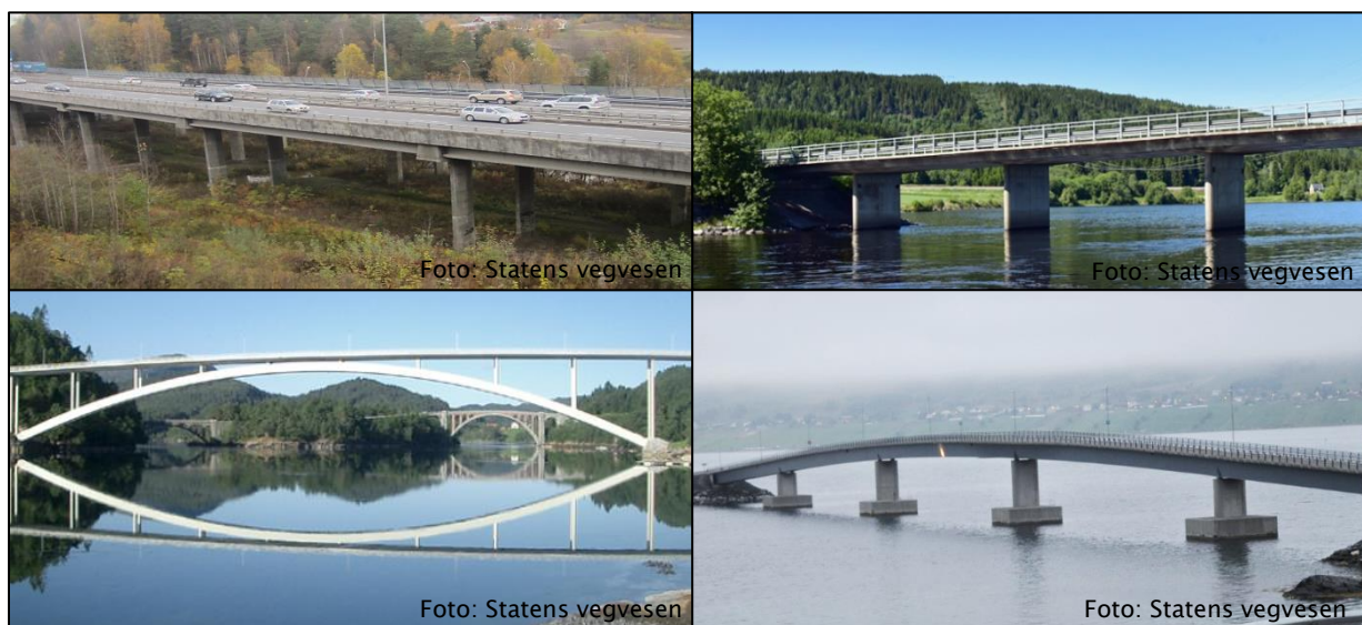
Figur 23: Oppe til venstre: Klemetsrud bru (prefabrikkerte betongbjelker), nede til venstre: Straumbua (buebru), nede til høyre: Kveøybrua (kassebru) og oppe til høyre: Fossebrua (platebru).
