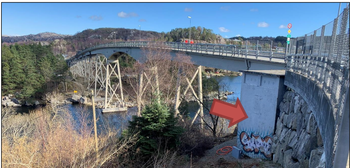
Figur 15: Rød pil viser trafoens plassering. Foto: Statens vegvesen, mars 2019.
