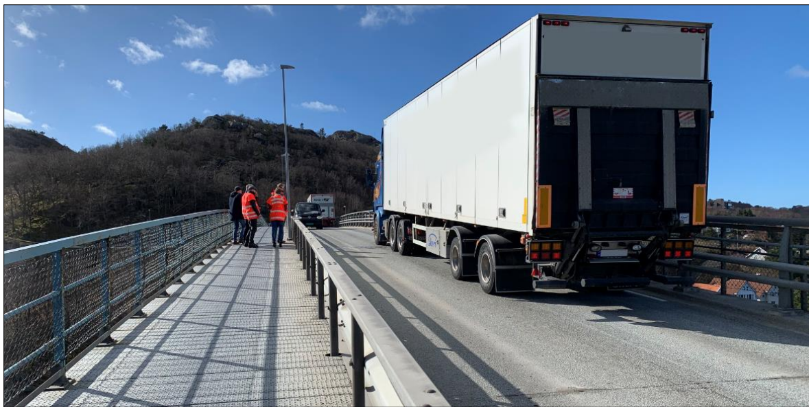
Figur 10: Smal bru med manglende midtoppmerking i kjørebane. Utfordrende dersom to større kjøretøy møtes. Foto: Statens vegvesen, mars 2019.
