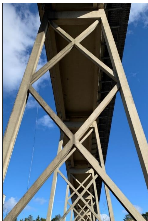
Figur 25: Undersiden av Eigerøy bru. Foto: Statens vegvesen, mars 2019.
