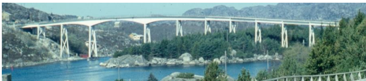
Bilde 1-1: Eigerøy bru sett fra sørsiden
