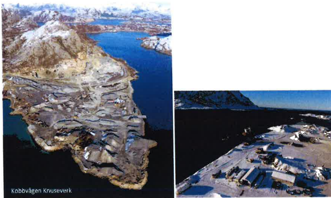
Figur27: bilder fra Kobbvågen Knuseverk, som viser knuseanlegg og lagerområder for stein i ulike fraksjoner. Utskipningen foregår i dag med båter opp til 5.000 tonn.
