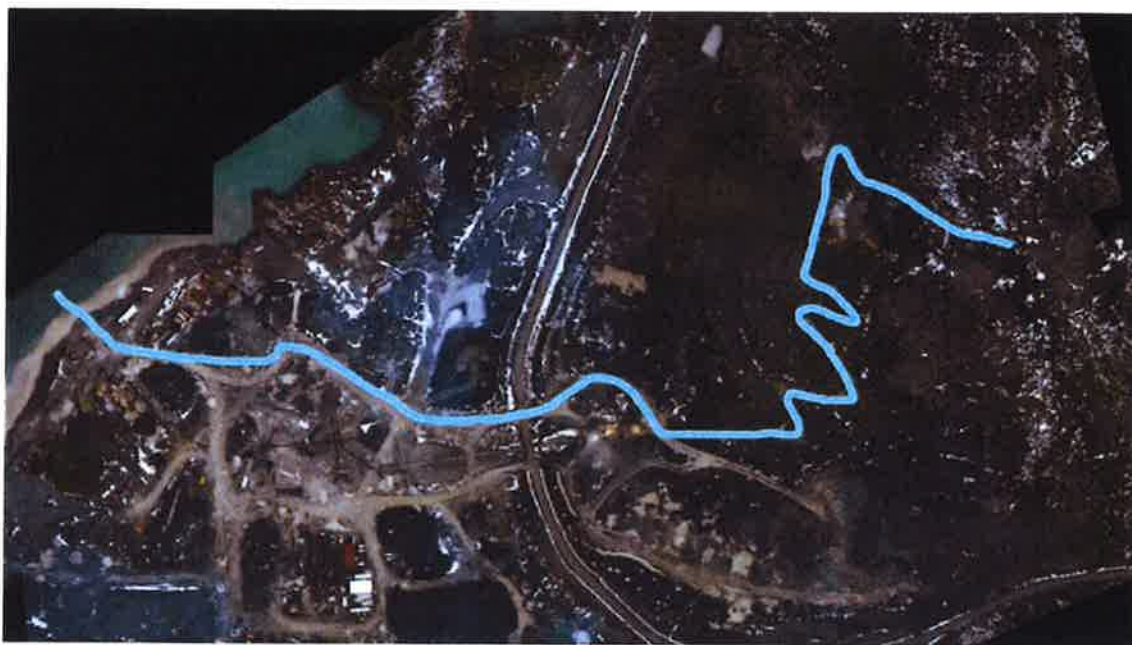
Figur26: Dronebildet fra vår 2019 viser endringer i steinbruddet. Driftsveier er bygget ut helt til toppen av uttaksområdet. Det er gjennom dette veisystem man vil transportere masser ned til fyllingsområdet.
