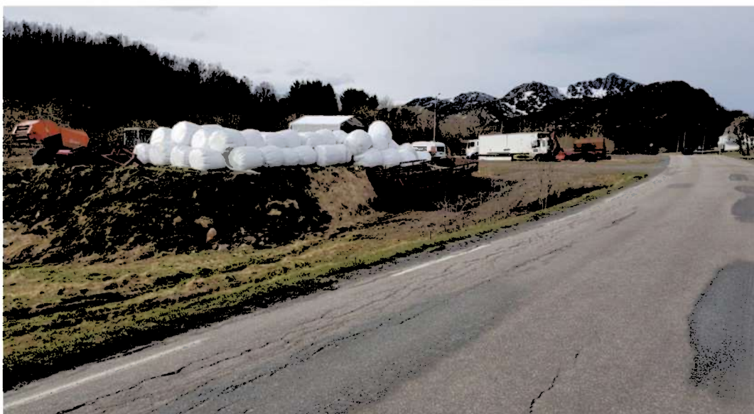
Utfyllt området på eiendommen 65/28 brukes til lagring av diverse «ting» i forbindelse med gårdsdrift. Avkjørselen er også en drivavkjørsel til omkringliggende jordbruksarealer.
