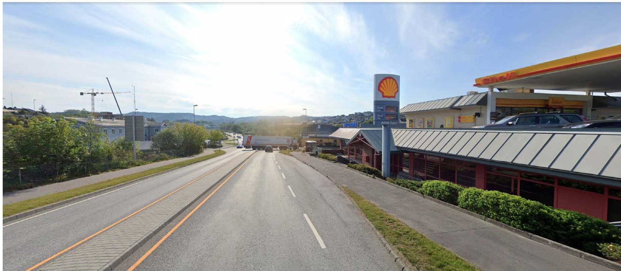
Langs Eigerøyveien, før.
