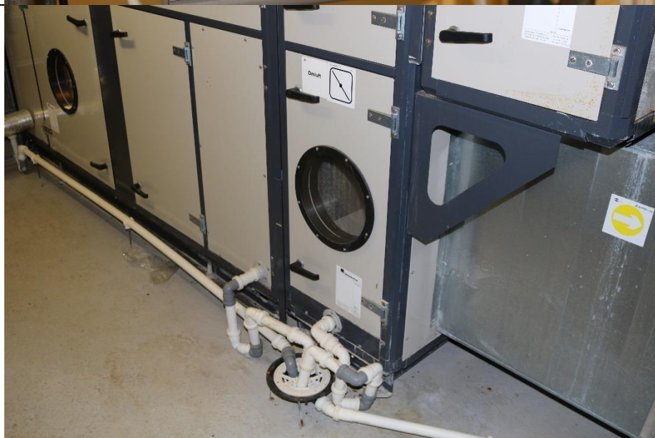
Varmegjenvinner for ventilasjonsanlegg.
