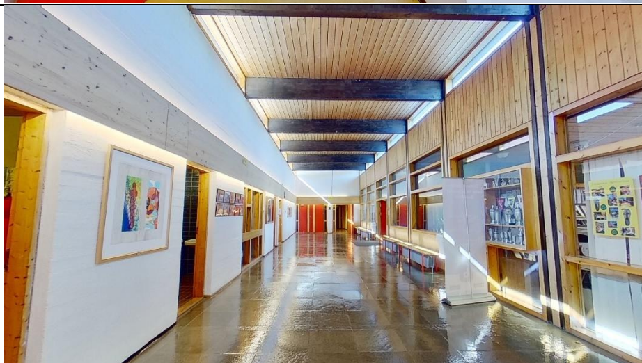
Belysning i adkomsthall er god når dagslyset kommer inn vinduer opp mot tak, men antas å være for svakt når kun skjulte lys bak skjørt på vegg er tilgjengelig (i mørketiden og på kveldstid).
