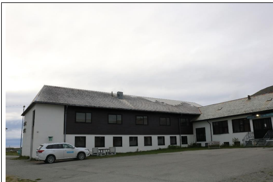
Vestfløy, yttervegg mot øst.
