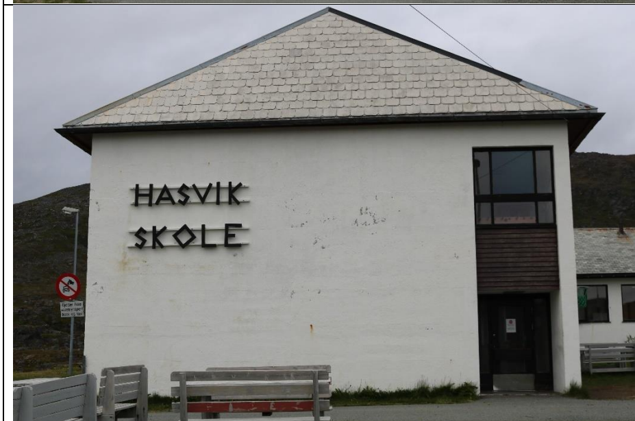
Yttervegg mot sør i vestfløy. Slitt og småskadet overflate. Avflakkende maling og betong/puss som har løsnet.
