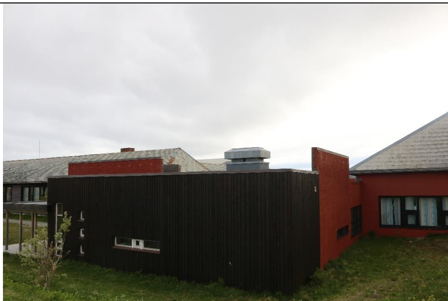
Oversiktsbilde, yttervegg mot øst i nordfløy (SFO).
