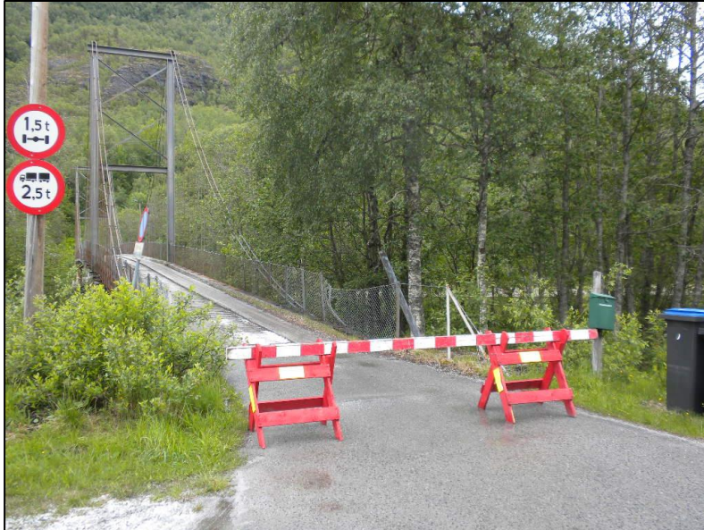
Bakken bru i Nordfjorden. Foto: Bente Braaten.
