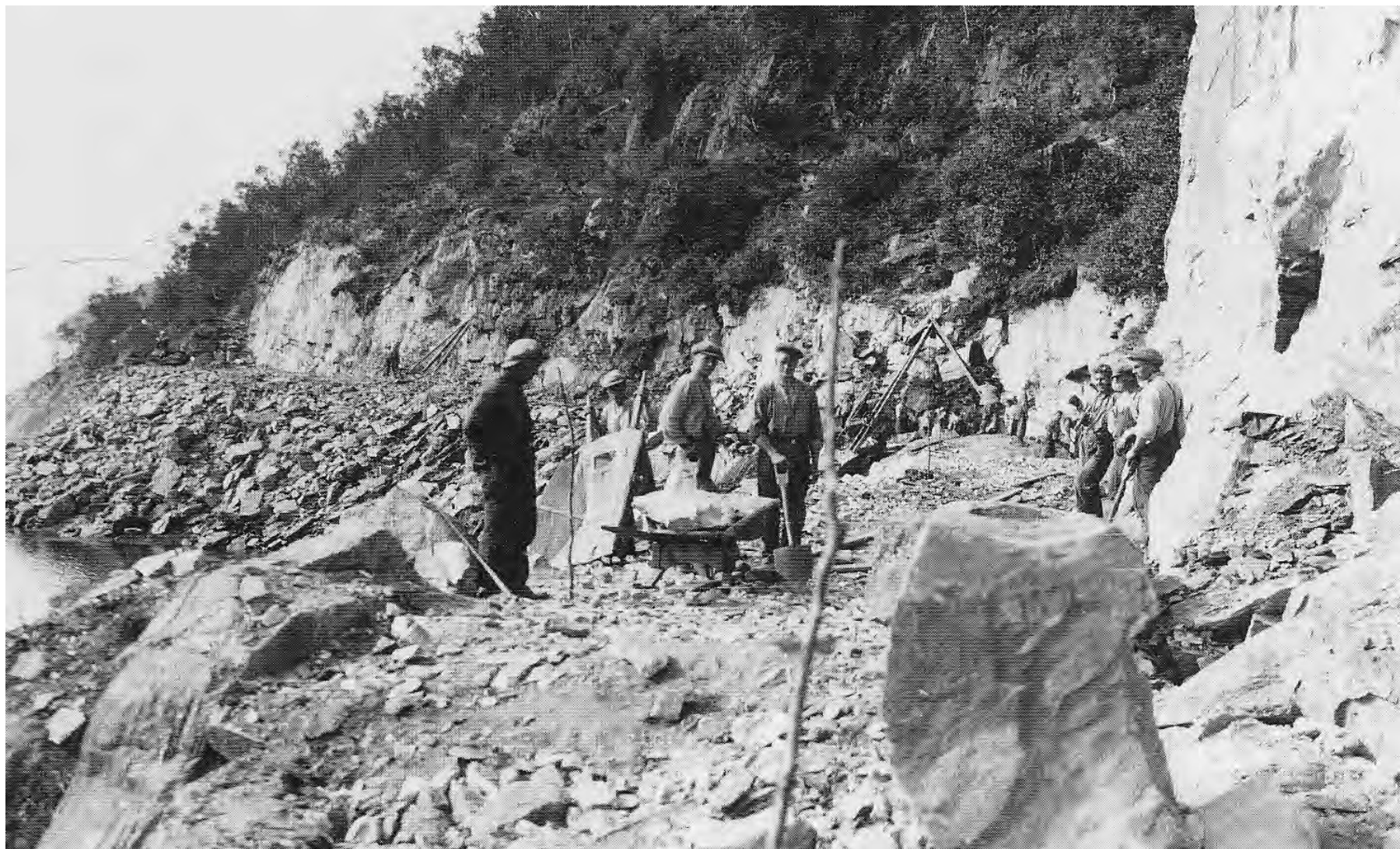
Syselsettingstiltak i Thomashola på framtidige Enganveien. (Veien blir ferdig først i 1969.)
