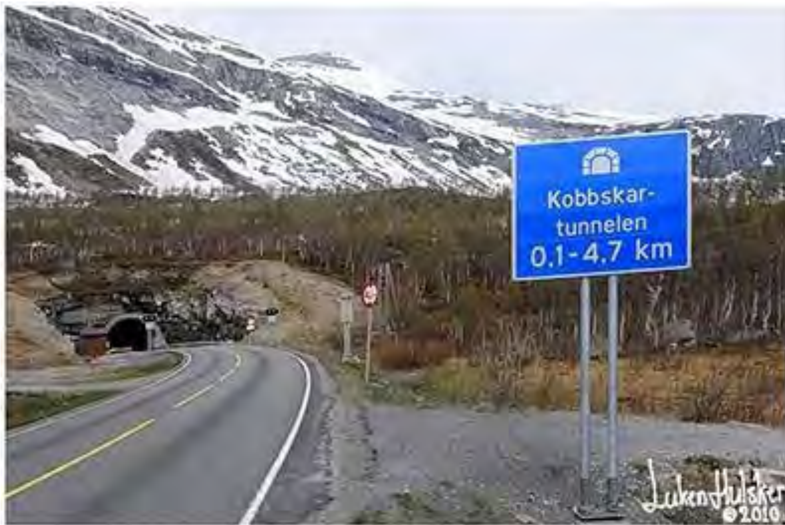
Kobbskartunnelen (4456 m) – en av de lengste på E6.
