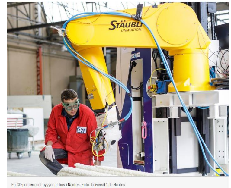
En 3D-printerrobot bygger et hus i Nantes. Foto: Université de Nantes
