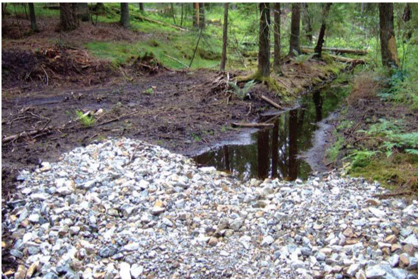
Figur 66. Det er bygget en rekke slike terskler i den grøfta myra sørvest for Griserud på Gjellebekk i 2009. Hver enkelt terskel gir en full oppdemming av vannet. Foto: Even W. Hanssen 2010.
