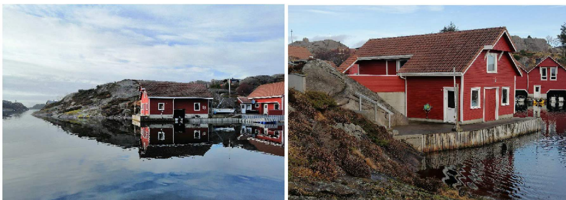
Figur 5: Eksisterende redskapsbod og bryggeanlegg. Foto: Privat
