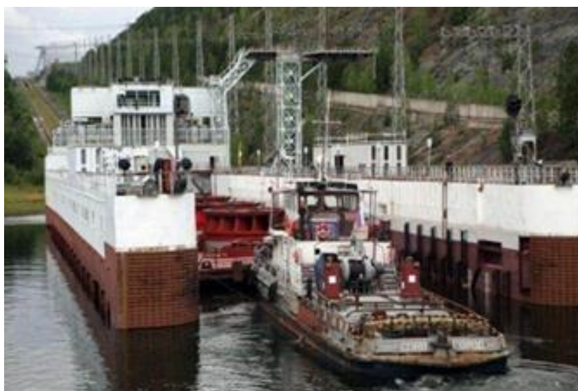
Bilde 26. Lekter skyves inn i slusekammeret = «vogna»
