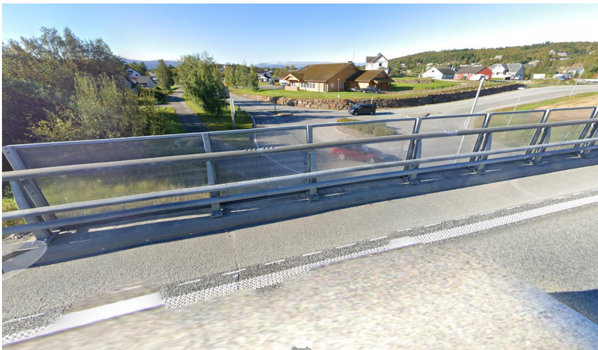
Figur 60: Flere rekkverksprodusenter har støyskjermer i glass som hektes på brurekkverket. Her fra Rv. 80 Strømsnes
