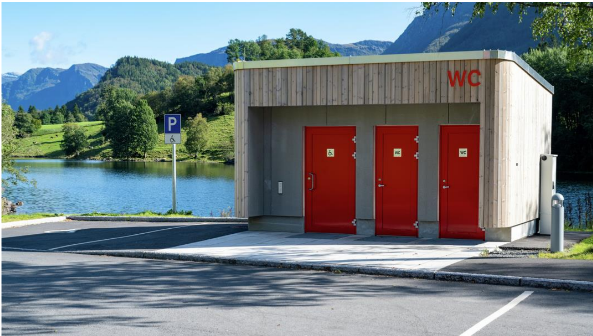
Figur 57: Toalettbygget på rasteplass E134 ved Haukalivegen
