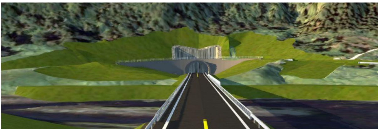
Figur 54: Tunnelportalen i Megården skal omrammes av tørrsteinsmur.
